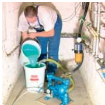
Befüllen einer Gasleitung mit PRODORAL®R 6-1
